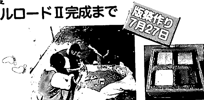
牛乳パックを再利用して製作した版築は全部で1000個以上作られました。
